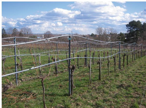
Abb. 15: Der vorgegebene Werkstoff Polyvinylchlorid ist aufgrund seiner physikalischen bzw. mechanisch-technologischen Eigenschaften (elastisch-plastische Verformung) für die Rohrleitungen der Applikationsanlage – erkennbar am Durchhängen der Leitungen – nicht geeignet.
