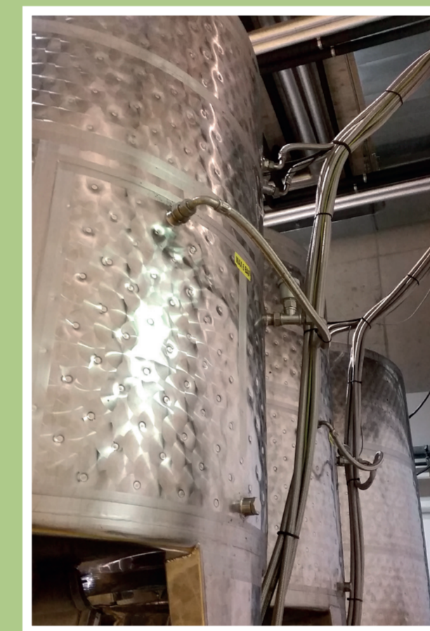
Modere Edelstahlanks mit Doppelmantelkühlung
